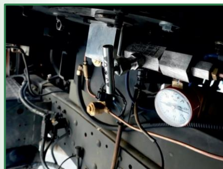
Тепловое устройство EVOLUTION 1 устанавливается на штатное место, вместо дизельной горелки.
