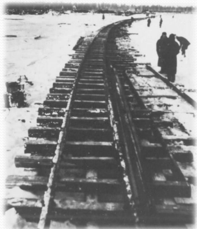
Строительство узкоколейной железной дороги по льду Ладожского озера в декабре 1942 года
