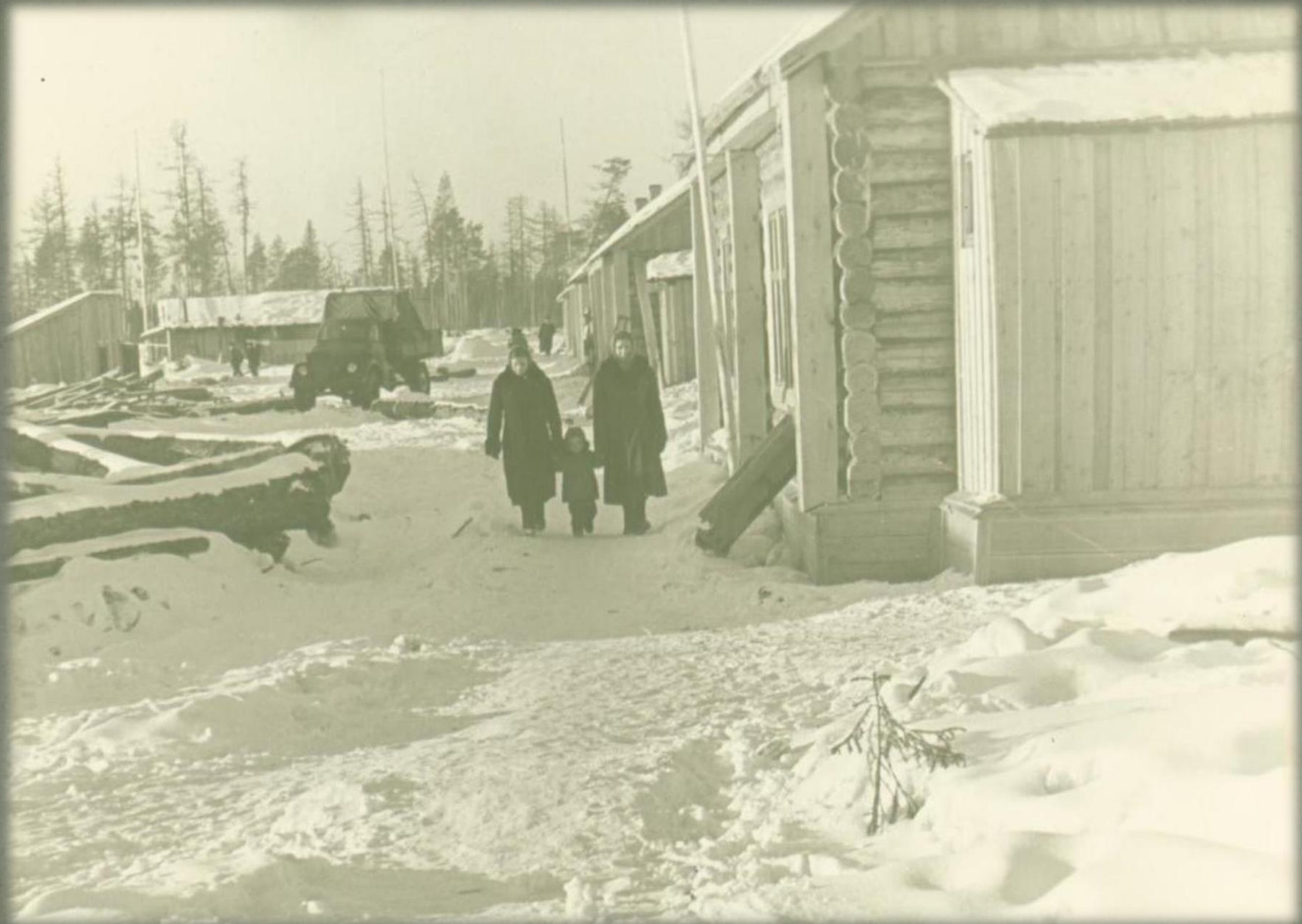
Строительство улицы Комсомольская. 1962 год. Фонд Фотодокументы. Опись 2. Дело 30. Лист 4.
