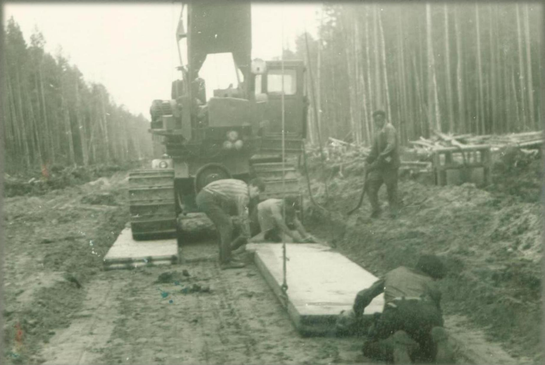
Строительство автодороги в сторону п. Комсомольский. 1962 год. Фонд Фотодокументы. Опись 2. Дело 30. Лист 7.
