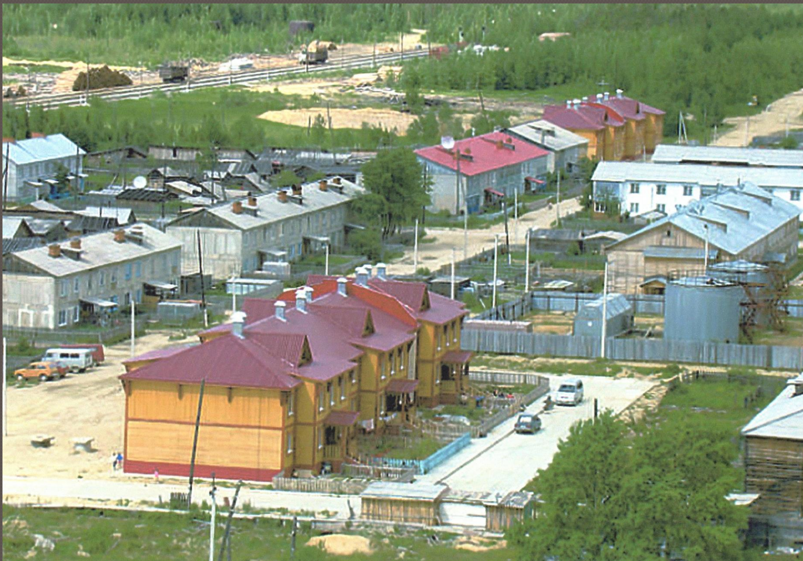
Новые 24-х квартирные жилые дома в жилом микрорайоне п. Агириш. 03 июля 2011 года.
