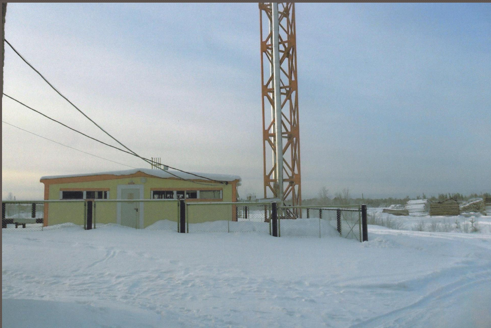
Здание газовой котельной введенной в эксплуатацию в п. Агириш в период 2009-2010 годы. 2014 год.
