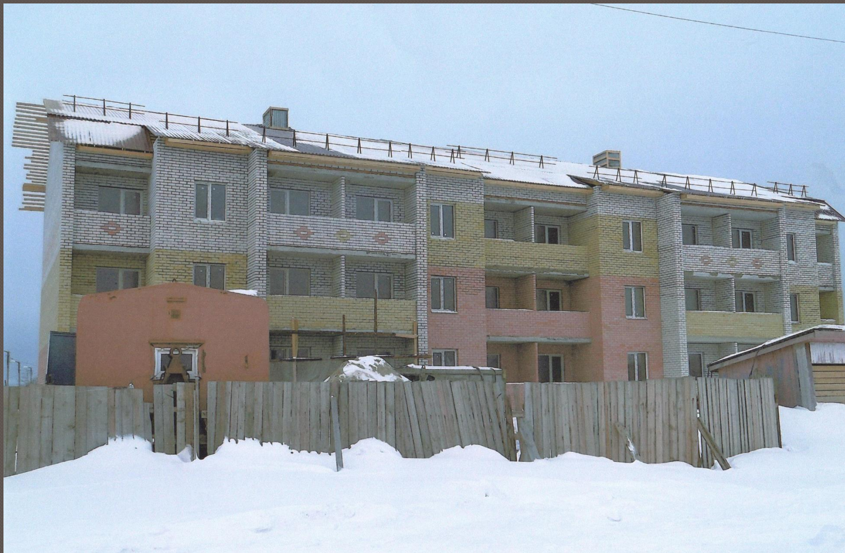
Строительство 3-х этажного жилого дома в поселке Агириш. 2014 год.
