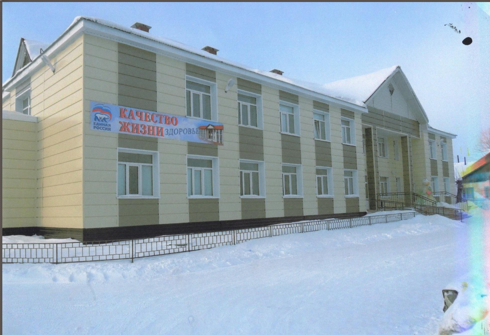
Здание Агиришской врачебной амбулатории после проведенного капитального ремонта. ноябрь 2011 года.
