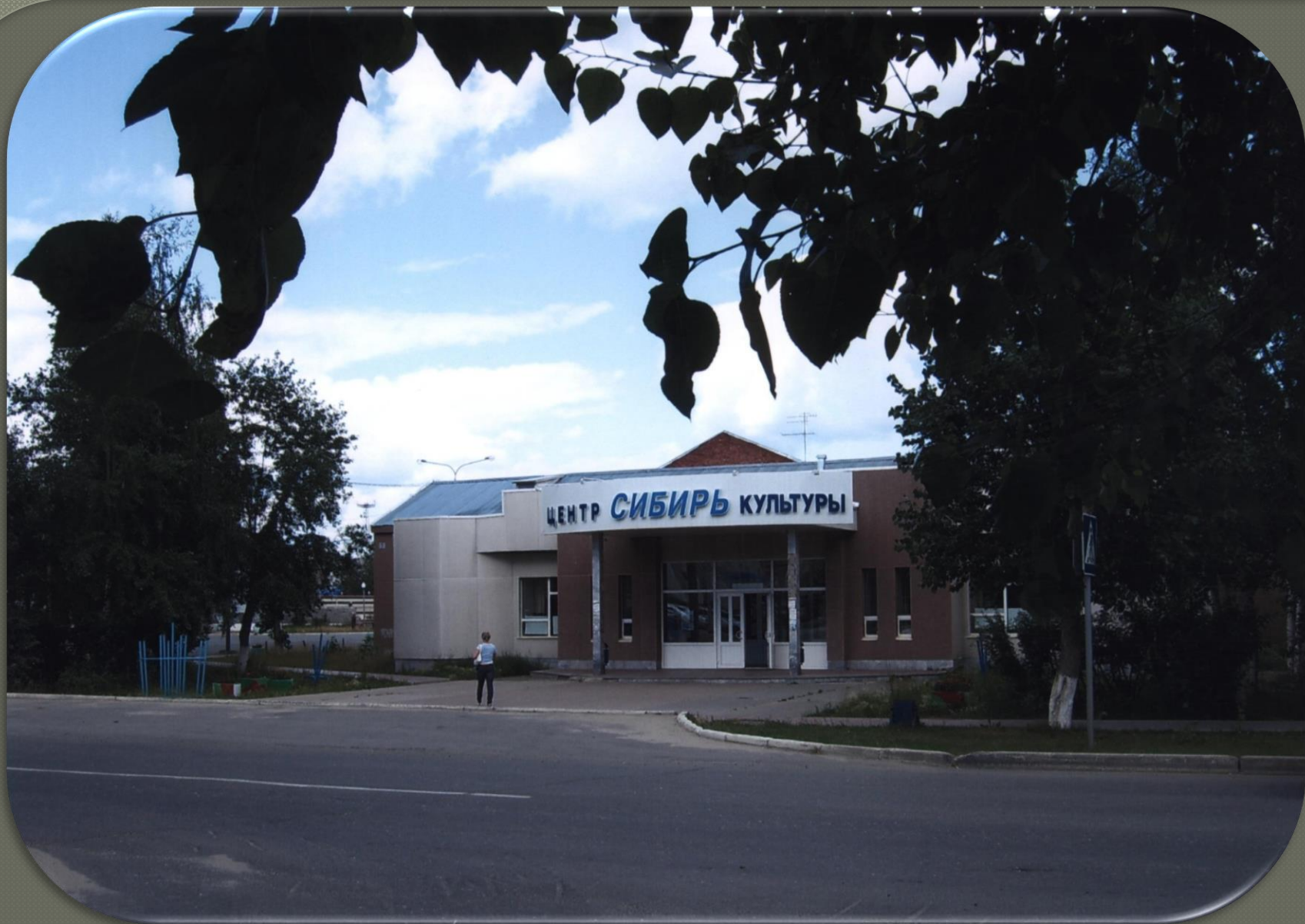
Общий вид здания центра культуры «Сибирь». г. Советский, ул. Ленина. 23.07.2008 года.
