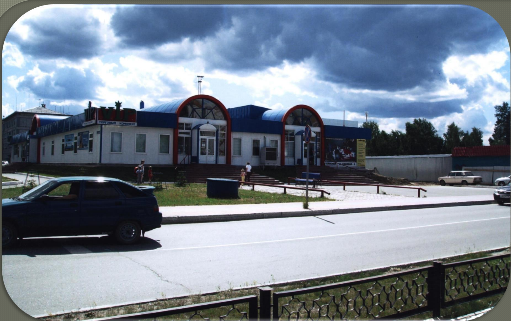
Общий вид здания торгового комплекса «УП». г. Советский, ул. Кирова-Гастелло. 23.07.2008 года.
