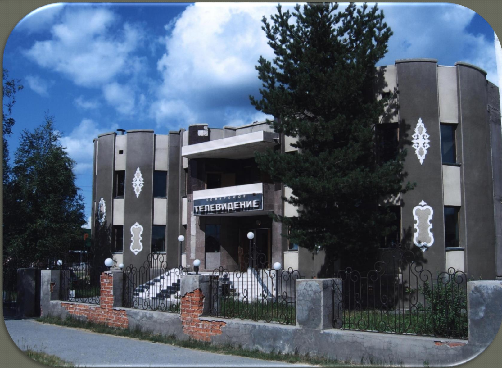
Общий вид здания районного телевидения. г. Советский, ул. Киевская. 23.07.2008 года.
