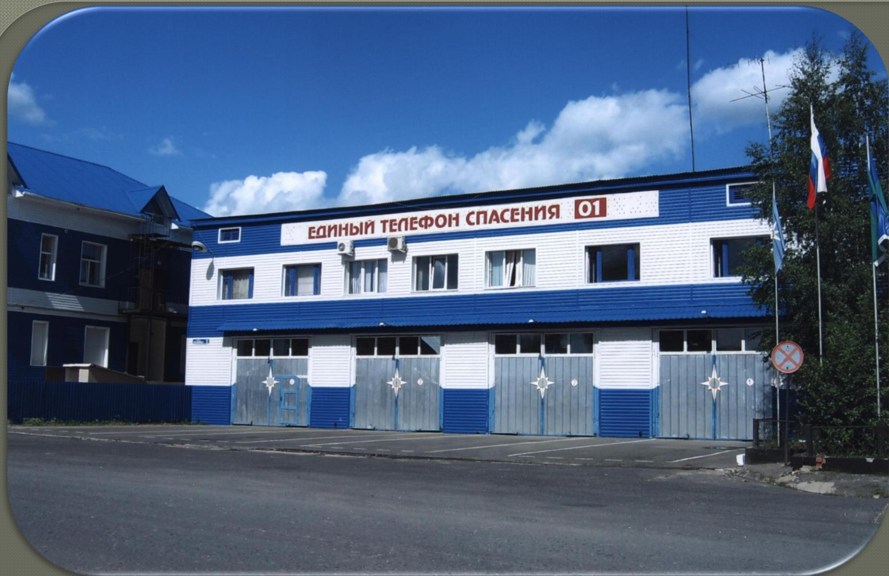
Общий вид административного здания Службы спасения, военизированной пожарной охраны. г. Советский ул. Ленина. 23.07.2008 года.
