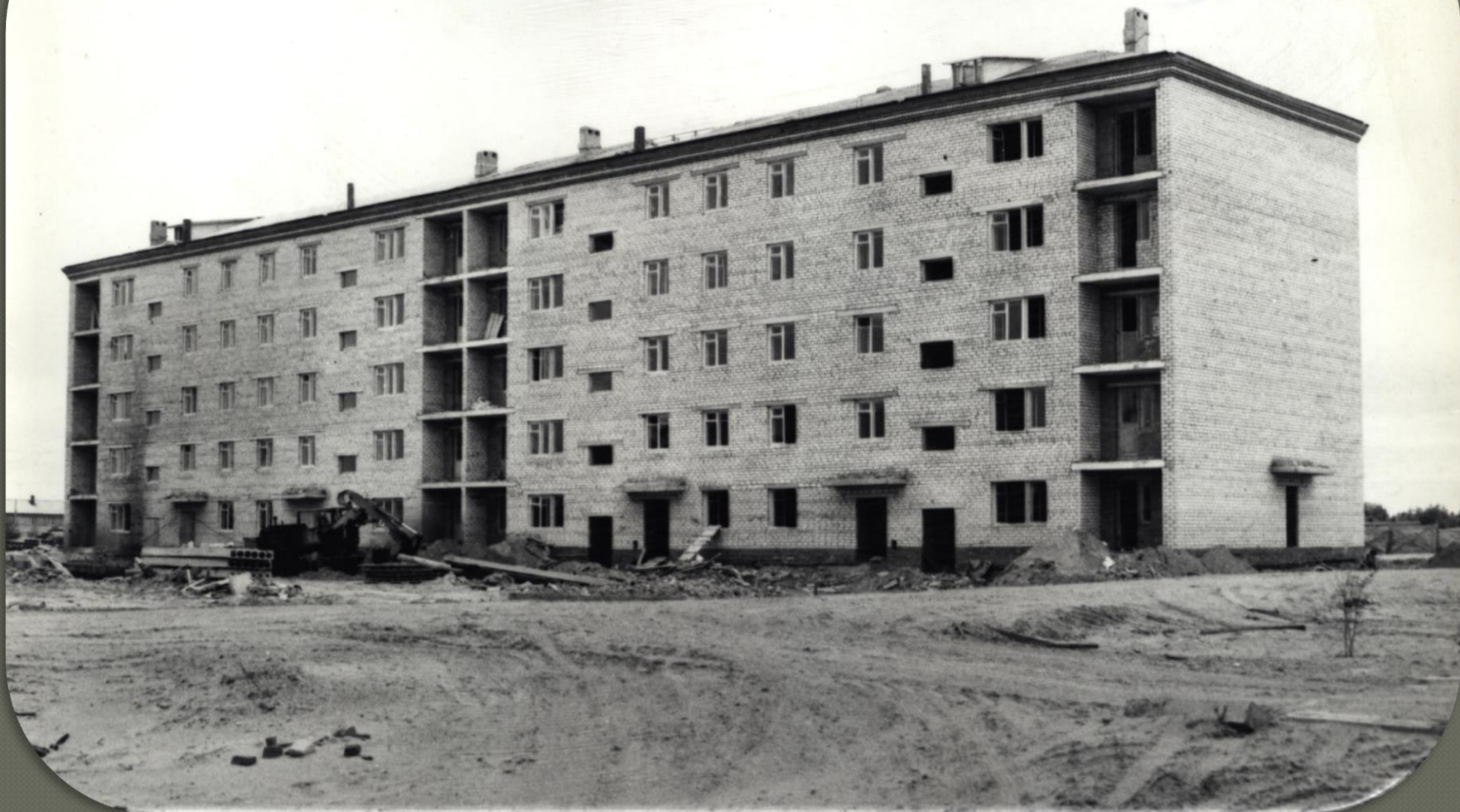
Строительство многоэтажного жилого дома Советского лесопильно - деревообрабатывающего комбината по ул. Киевской . п. Советский. 1984 год.
