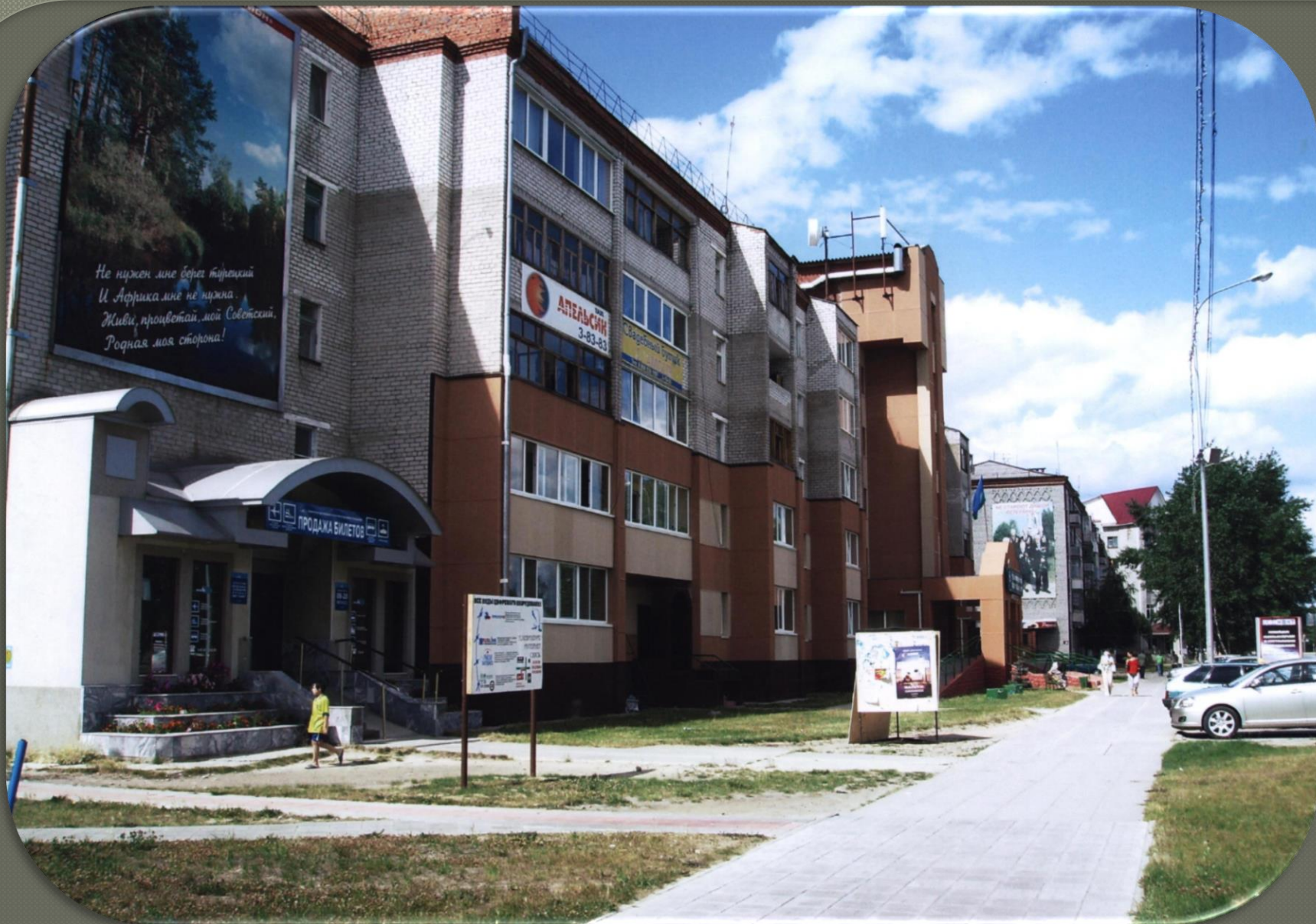
Общий вид многоэтажных жилых домов по ул. Гастелло. г. Советский. 23.07.2008 года.
