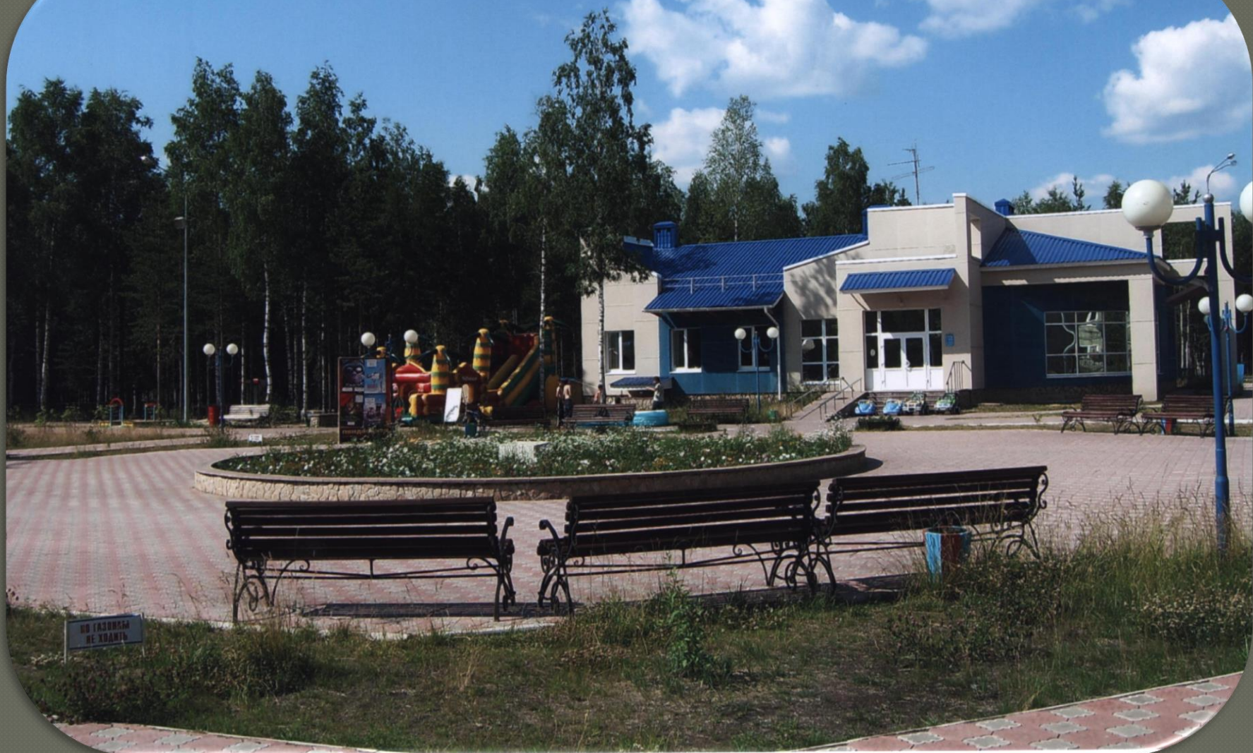
Общий вид административного здания в городском парке и прилегающей территории к зданию. г. Советский, ул. Макаренко. 23.07.2008 года.
