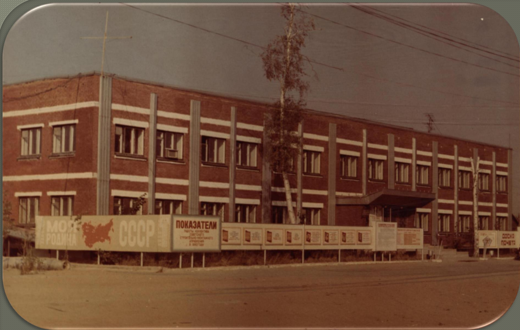
Административное здание Советского строительно-монтажного управления. п. Советский, ул. Калинина. 1980 год.
